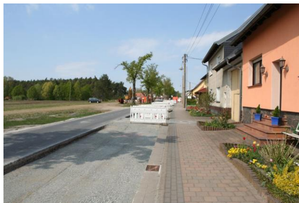
Jüterboger Allee /L 111 (Baustellenbereich)
