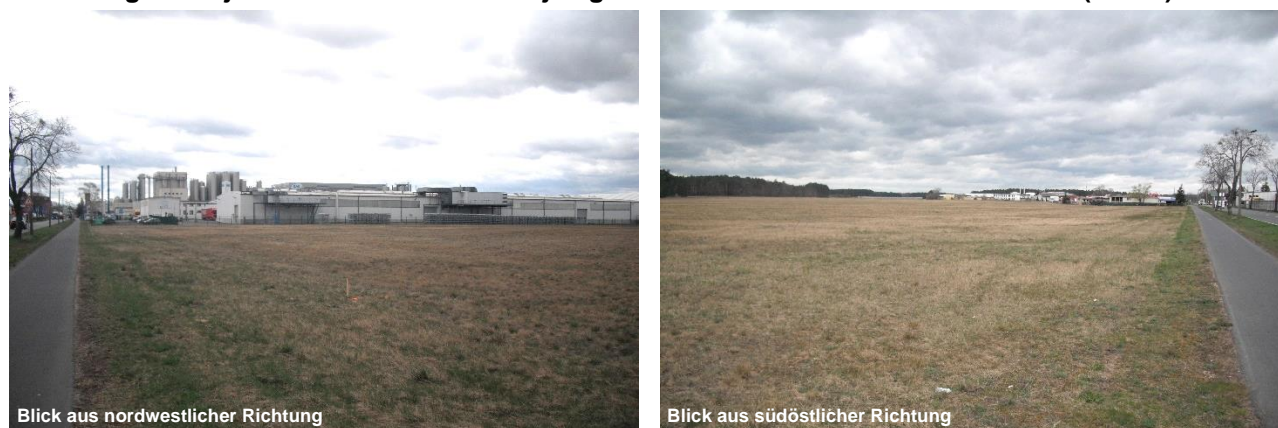
Abbildung 1: Objektsituation auf dem Projektgrundstück Rehainer Straße in Jessen (Elster)
