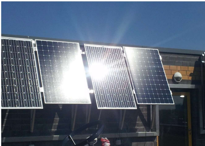
Abbildung 3: Veranschaulichung der Reflexion an einem texturierten Modulglas (mitte-links) und einem glatten Modulglas (mitte-rechts) – Quelle Aufnahme: Fraunhofer-Institut für Solare Energiesysteme ISE
