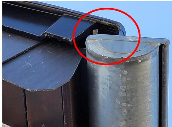
**Abbildung 19: Gebäude 2b, Öffnung im Traufbereich an einer Gebäudeecke**
