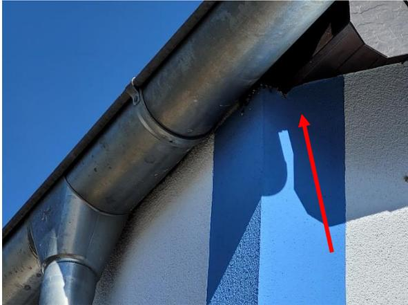
**Abbildung 20: Gebäude 2b, Öffnung im Traufbereich an südwestlicher Gebäudeecke mit Vogelkot**
