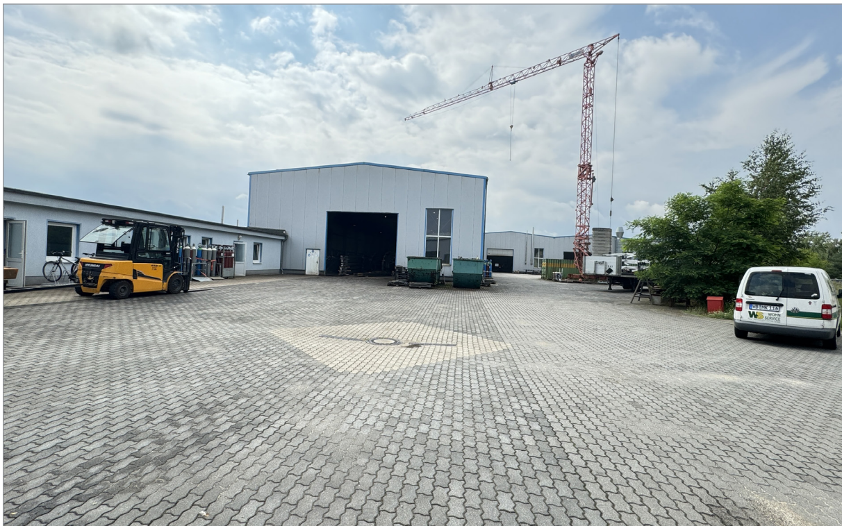
Abbildung 4-2 Blick auf Südostfassade
